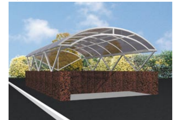
Рисунок 99. Типичная арочная конструкция укрывающего ограждения подземного перехода.
