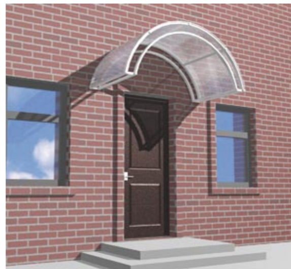
Рисунок 58. Арочная конструкция козырька.
